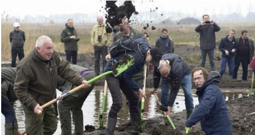
Doorsteken van dam in de Kromme Eem, als opening van de werkzaamheden.
