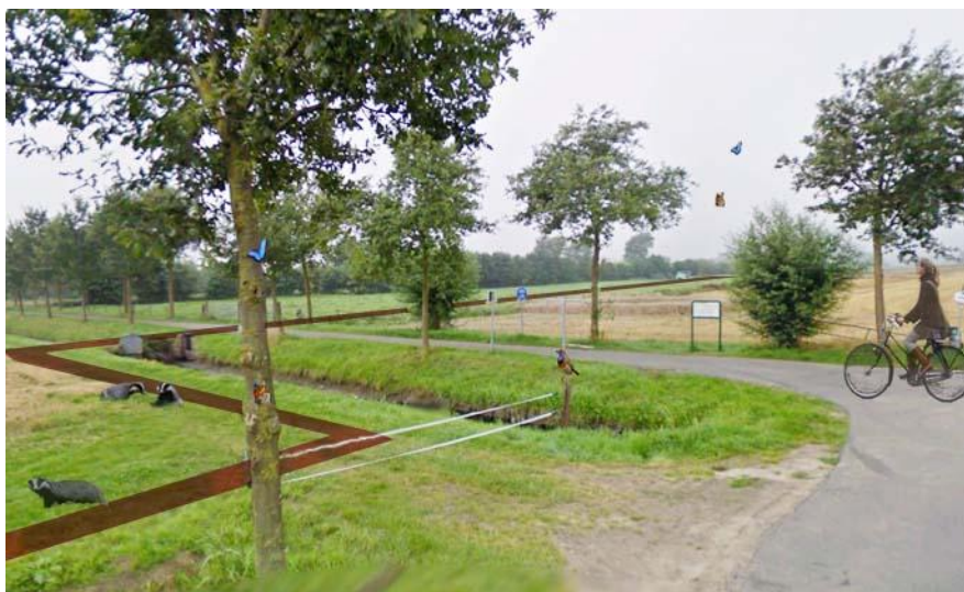
Foto 8. Dijkgraaf weg en Unifarm perceel.
